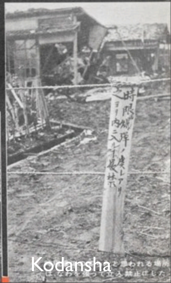
初空襲でむざんに破壊された東京荒川区尾久の民家。250・爆弾で、一家6人が犠牲になった。
